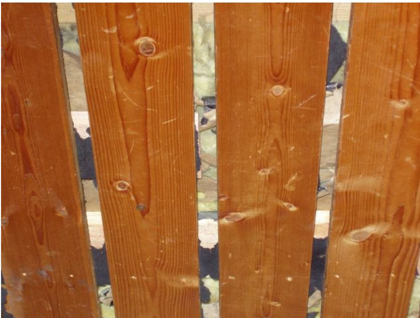
Abbildung 6: Holzpaneeldecke mit zum Teil freiliegenden KMF
